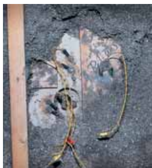
Abb. 3: Feuchtemessstellen an der kalten Seite der Dämmebene.
