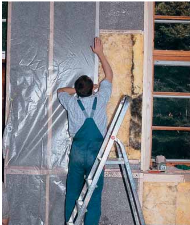
Abb.1: Innendämmung – mit oder ohne Dampfbremse? Start eines Langzeitversuchs September 1988 mit verschiedenen Dämmstoffen und hohen Dämmdicken.
