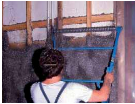
Abb. 4: Dämmung mit isofloc im cso- Anspritzverfahren.
